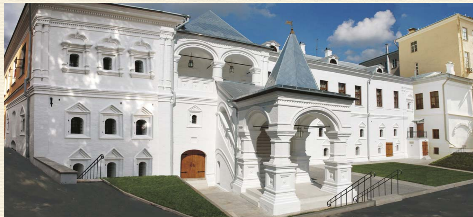
Панорама дворового фасада с воссозданным «Красным» крыльцом XVII века после полного завершения реставрационных работ. Август 2006 года
