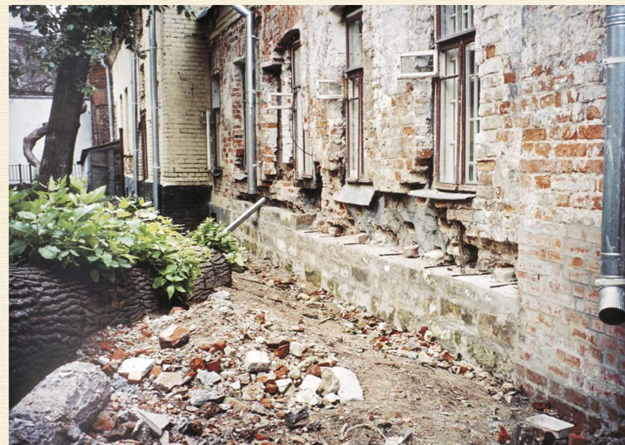
Фрагмент дворового фасада в процессе реставрации. 2003
