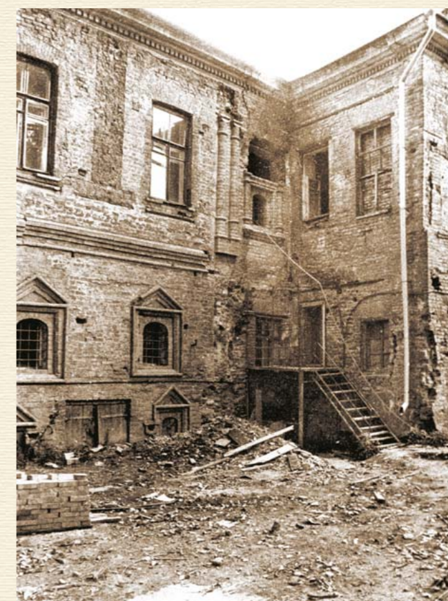
Фрагмент правого крыла дворового фасада в ходе реставрационных работ. 1996
