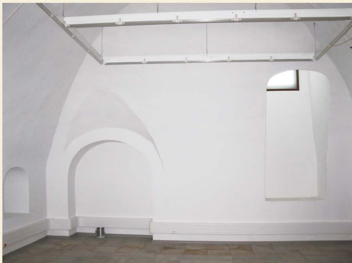
Белокаменный подвал северного ризалита отреставрирован в 1996–1997 годах
