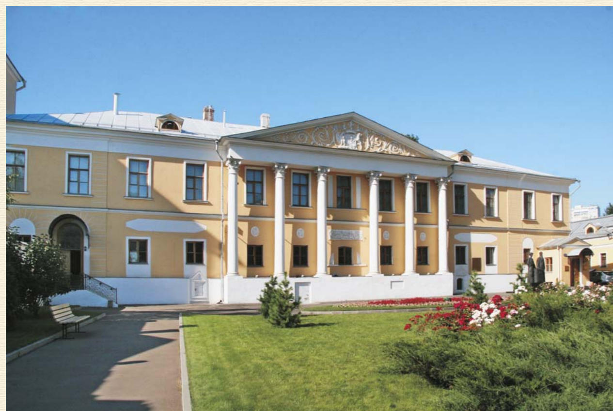
Реставрация главного фасада завершена в 1996 году
