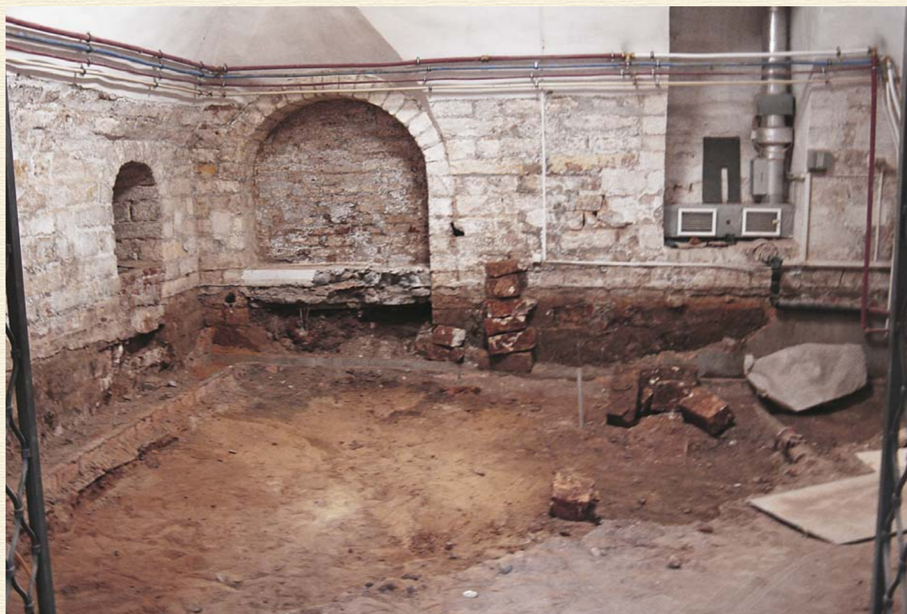
Белокаменный подвал северного ризалита
