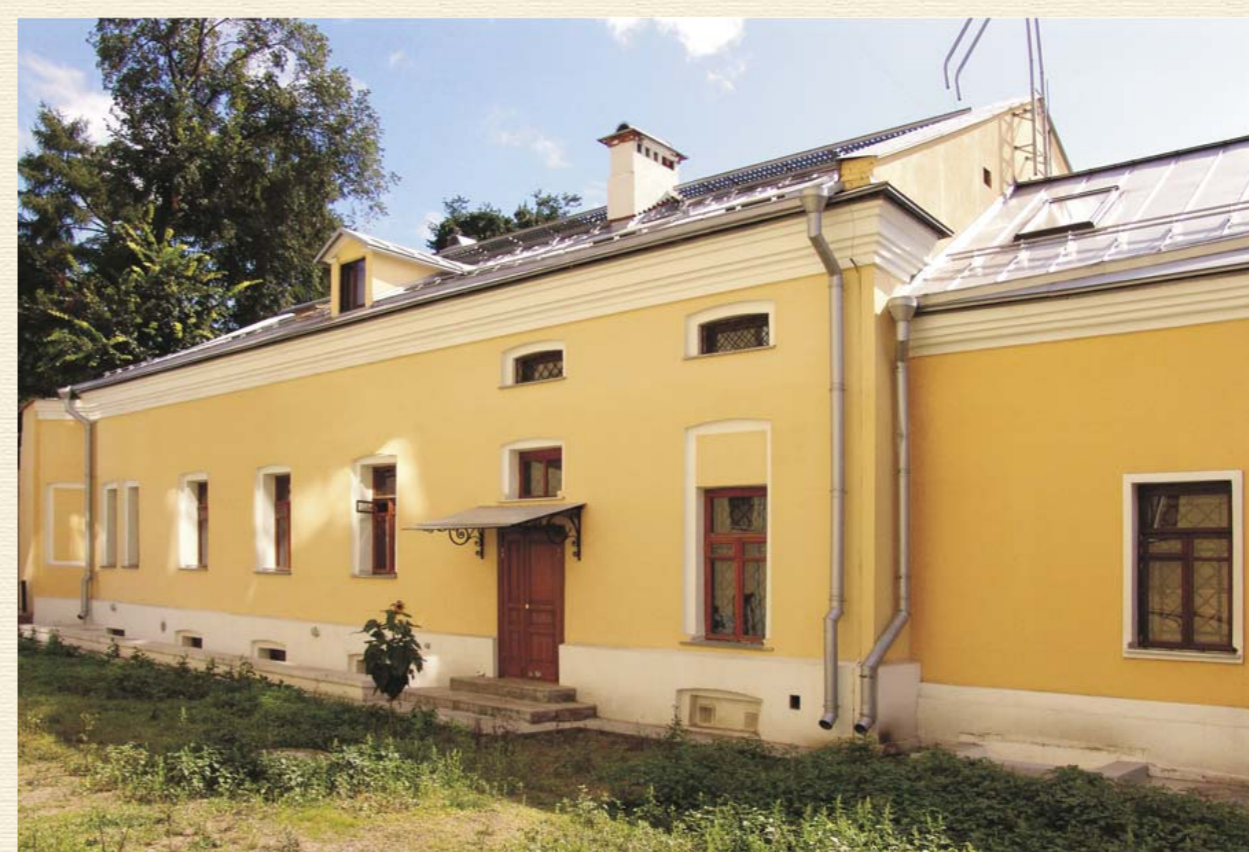
Фрагмент дворового фасада. 2004
